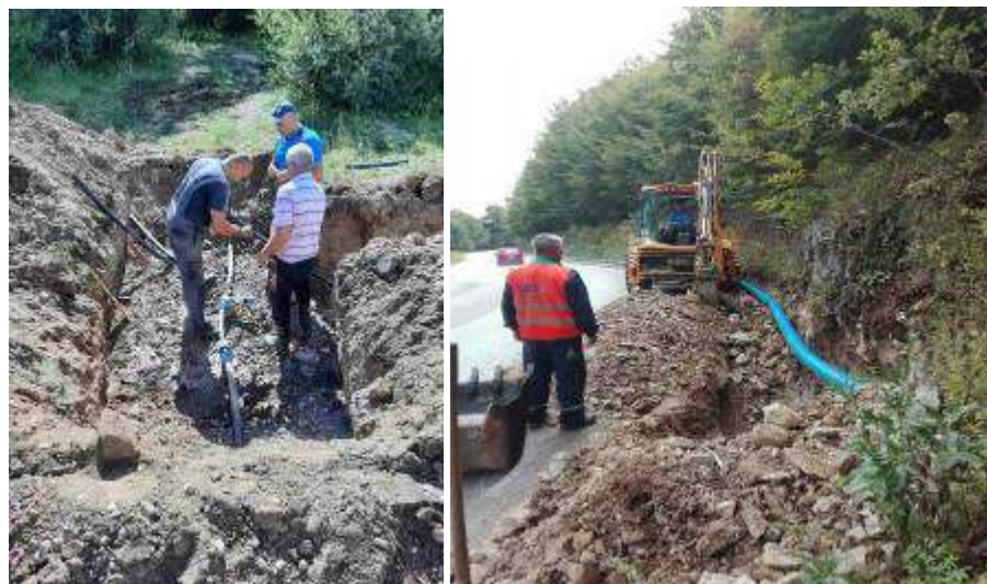
Slika 56. Izgradnja vodovoda Izvor: Općina Trnovo
